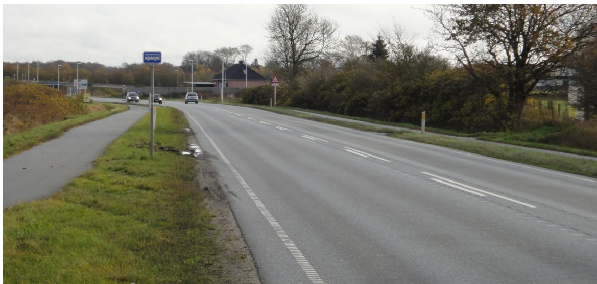
Figur 14 Busholdeplads v. km 6/0734 i VHS. Set fra vest
