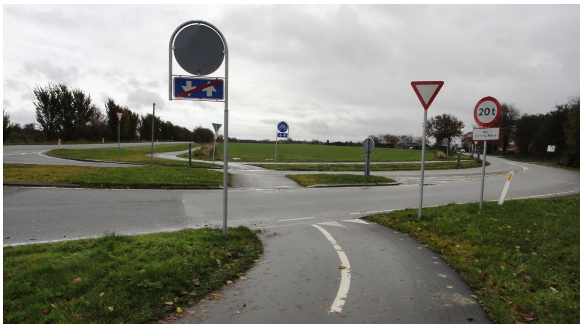
Figur 17 Tilbagetrukket cykelsti ved Hammelev Bygade. Set fra vest
