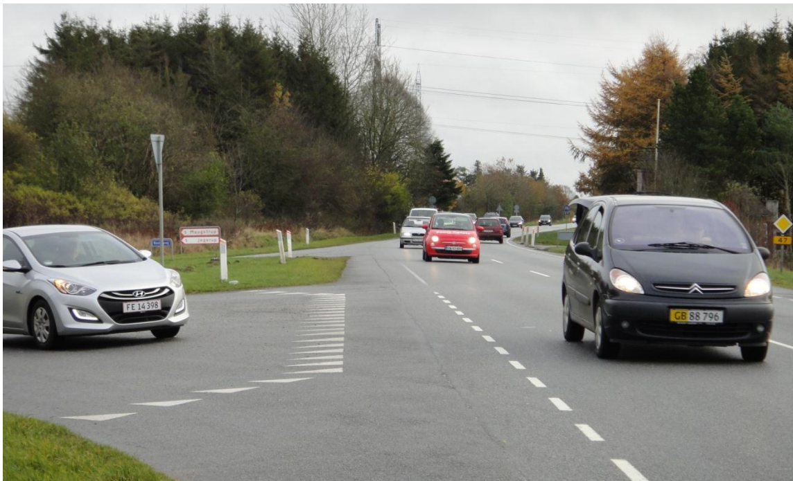
Figur 20 3-benet kryds Kestrupvej/Ribevej. Set fra vest
