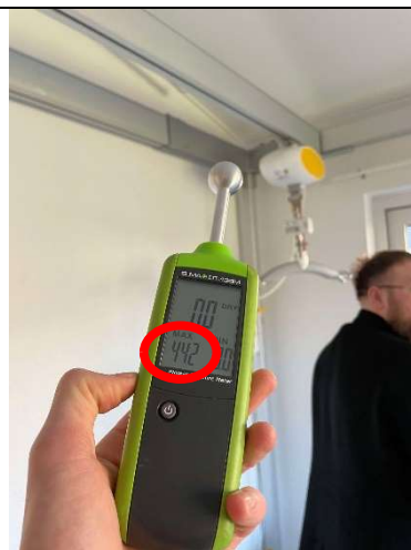
Kapacitiv fugtmåling ved 0580 (44,2 digits)
