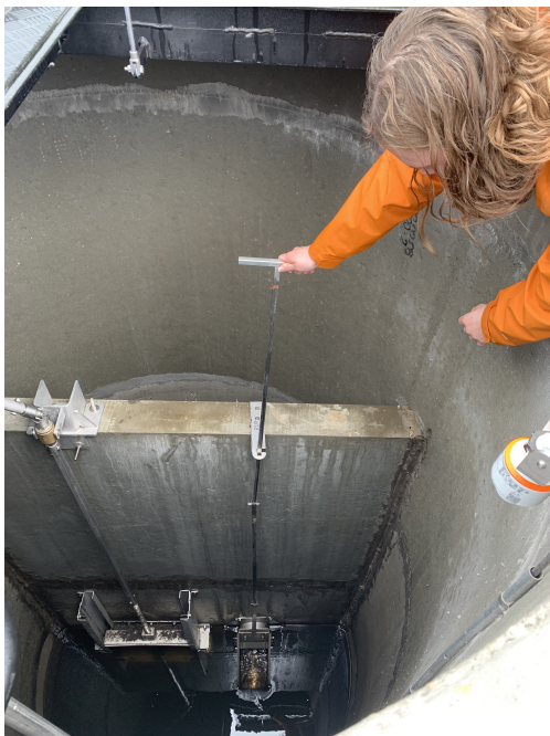
(a) Åben udløbsbrønd ved Svenstrup Banevej Bassin
