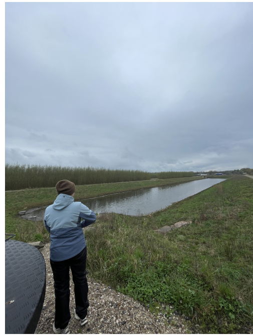
(b) Fra øst hvor udløbsbrønden er synlig nederst i venstre hjørne.
