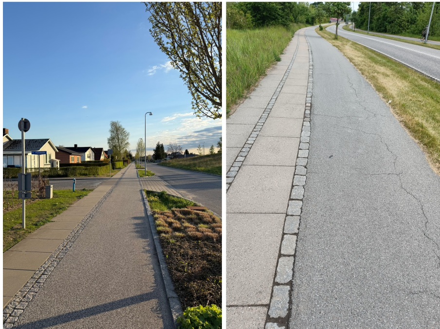
Figur 6.3. Billedet til venstre viser Supercykelstien mellem Horsens og Hedensted, her er supercykelstien målt af projektgruppen til at være 1,5 meter bred. Billedet til Højre er supercykelstien mellem Frederikssund og København ved Frederikssund, her er supercykelstien 1.9 meter bred. Billedet til højre er(Egne billeder)
