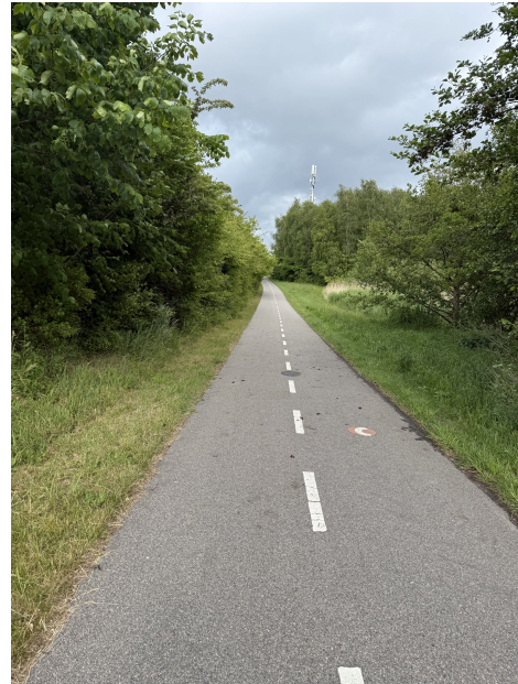
Figur 6.6. Supercykelsti uden for Frederikssund. Eksempel på manglende belysning (Eget billede)
