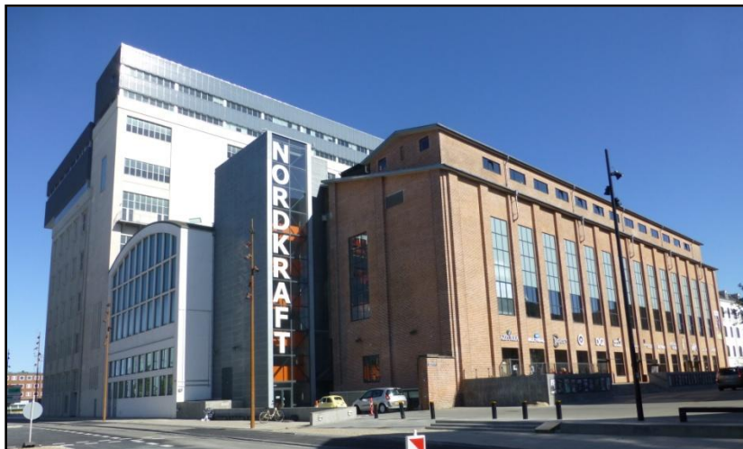
Figur 16 - Viser Nordkraft efter ombygningen.
