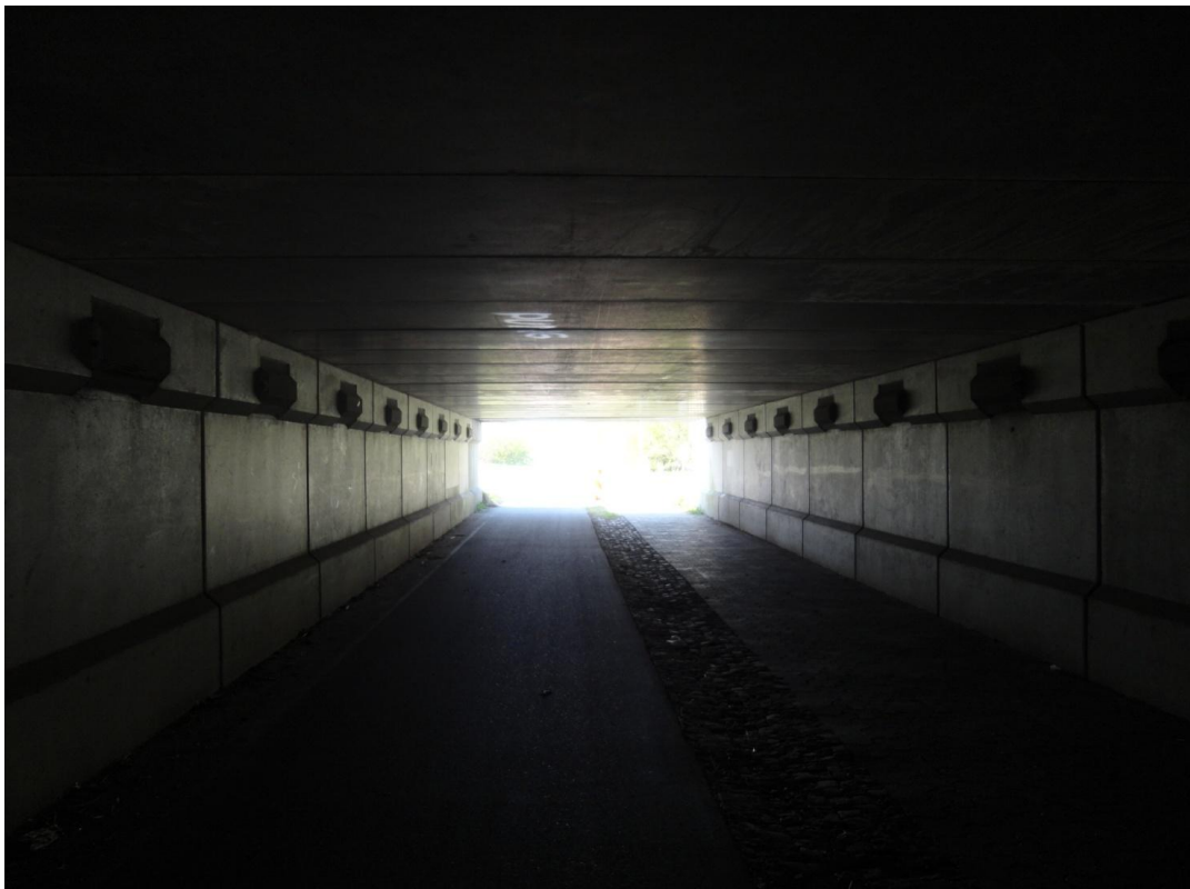
Billede 7: Gjellerupstien set fra syd mod nord indefra tunnellen
