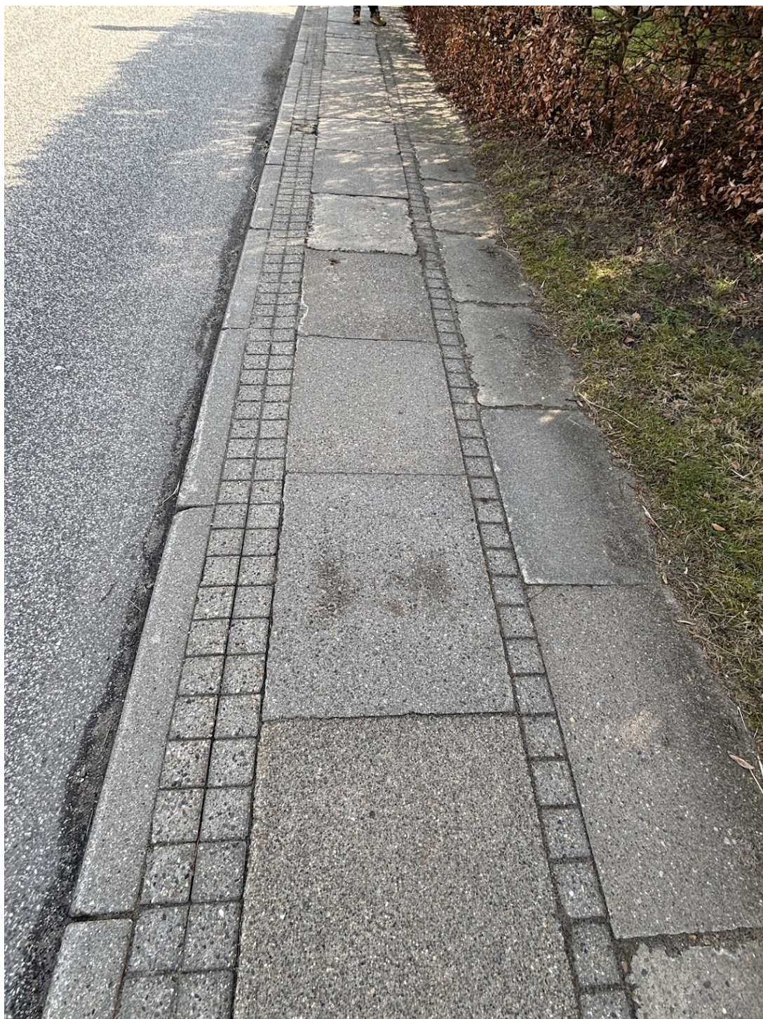
Figur B.4 Billede af eksisterende fortov på Uggerhalnevej.
