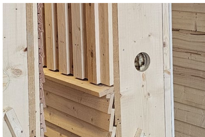
Figur 30. Foto af væg 3, taget under installationen af sensorerne i væggene. På baggrund af kophullets placering forventes sensorerne at være placeret i højden bag 1-på-2 beklædningen på væggen øvre del. Efterfølgende blev hullet lukket og forseglet med akrylfugemasse. Sensorplaceringerne og -installation er beskrevet under kap. 5.3.1 Væg- og sensorplaceringer .
