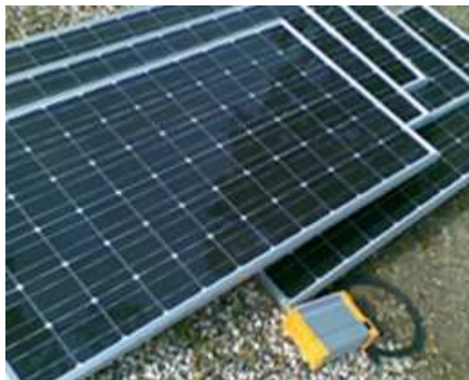
Billede 1: Monokrystallinske solceller.
