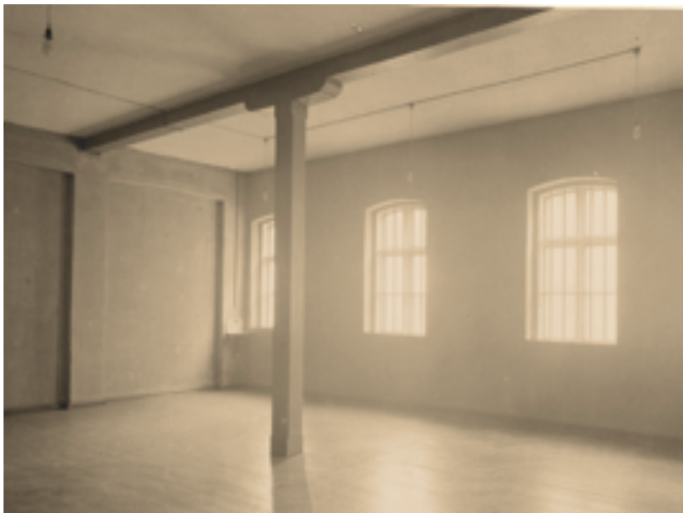
Figur 14. Billede af en tom arbejdsstue i tugthuset, som den så ud i 1928. 239
