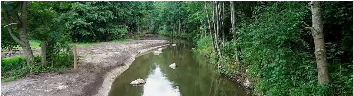
Figur 4.2: Billede af stenudlægninger i Langvad Å. [NIRAS 2023]
