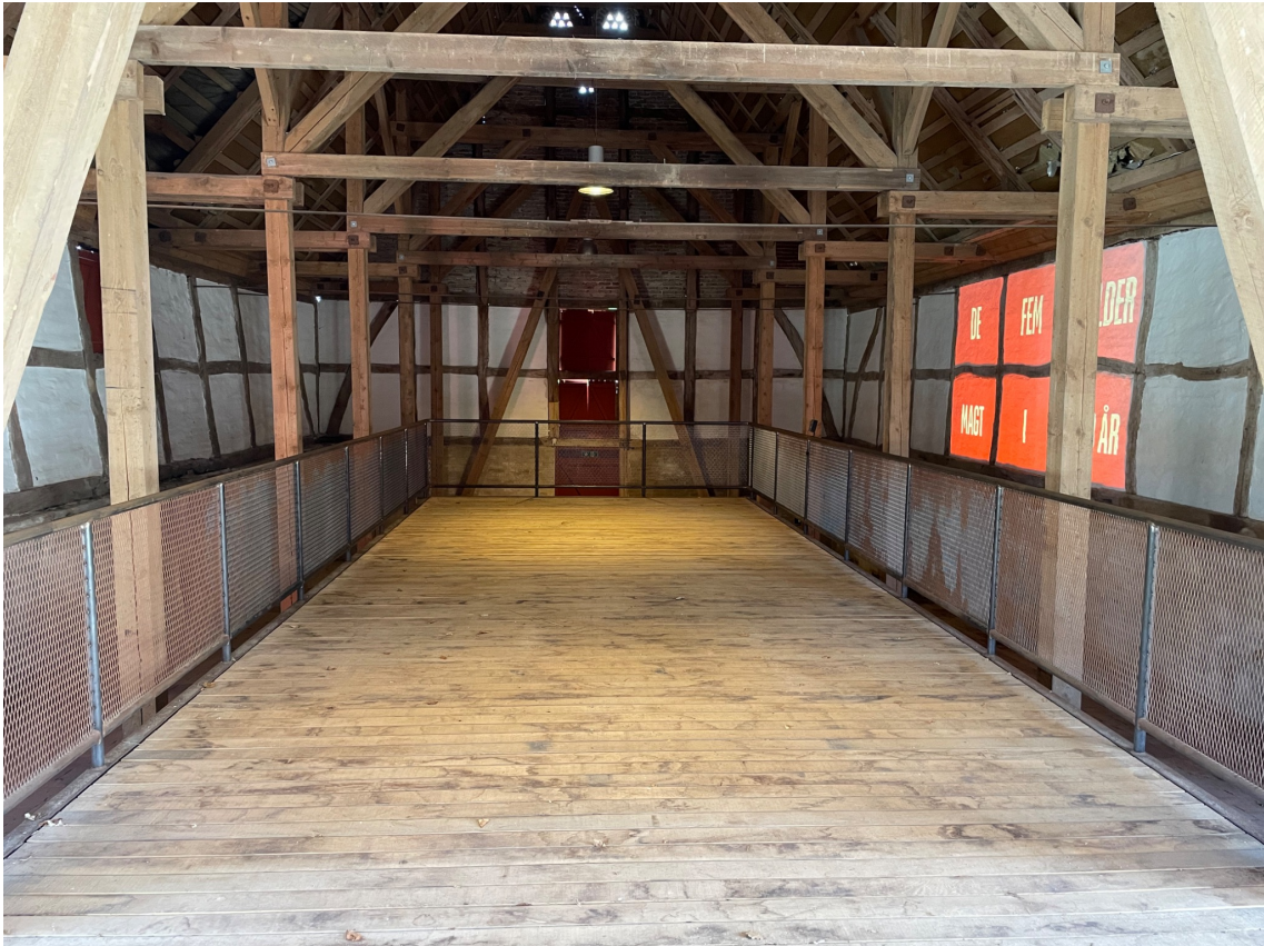
Billede 19: Haldladens gangbro (privat foto).
