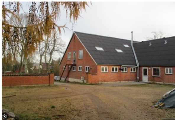
Figur 17 -viser 5 ældre bygninger fra før 1961.
