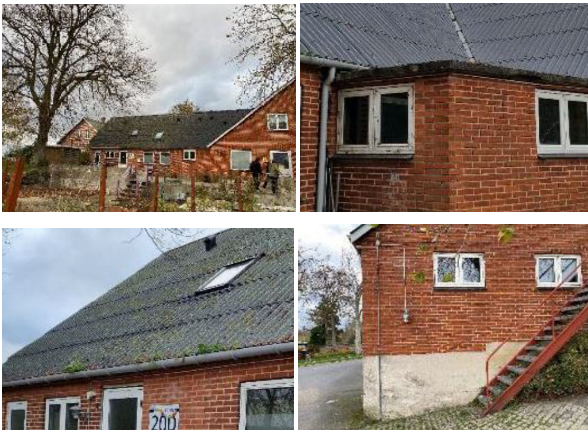
Figur 24 - Facader, sokler og tilstand af tagrender og tag. (Kilde: tilstandsrapport.)
