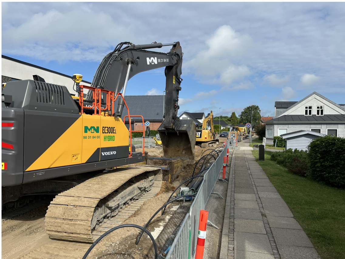
Figur 6.1. Anlægsarbejde på et vejareal omfattet af Vejloven.
