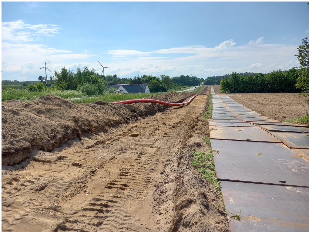
Figur 3.3. Anbringelse af forsyningsledning i et privat areal.
