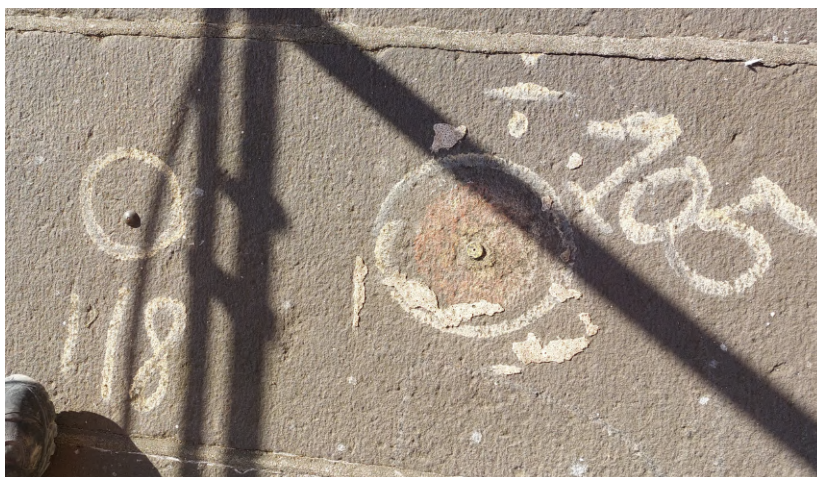
Figure 3.8. Eksempel på den fysiske afmærkning af punkter [Eget billedmateriale].
