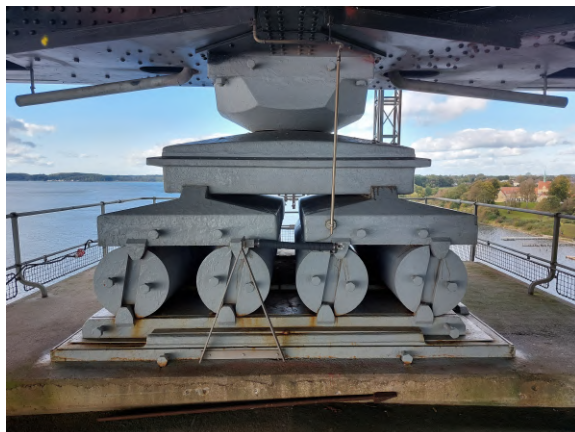
Figure 3.3. Rullelejlre på pille 4 i den vestlige side. [Eget billed materiale]
