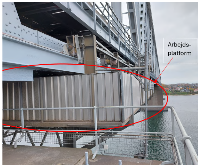
Figure 7.1. Billede af arbejdsplatformens placering ift. pillerne [Eget billedemateriale].
