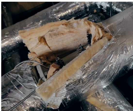
Figur B.4. Påsætning af klemmer på returløb til veksler på sekundærsiden
