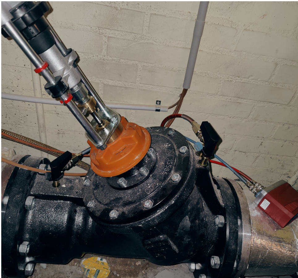
Figur 5.14. IMI TA-modulator motorventil til flowregulering for alle kredse
