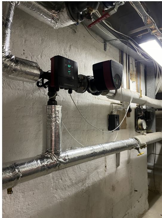
Figur 2.12. Billede af opsætning for blandesløjfe
