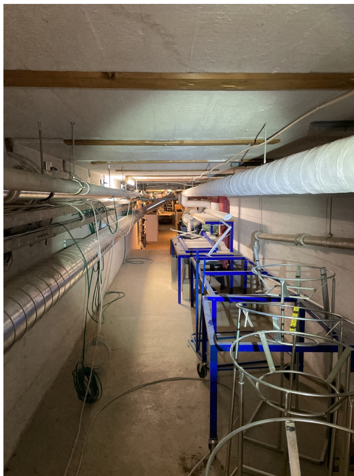
Figur 2.10. Billede af ingeniørgange under hallen
