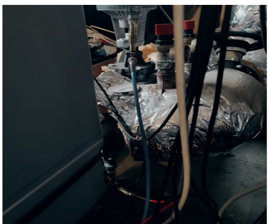
Figur B.6. Påsætning af målestudser på frem- og returløb til veksler på sekundærsiden
