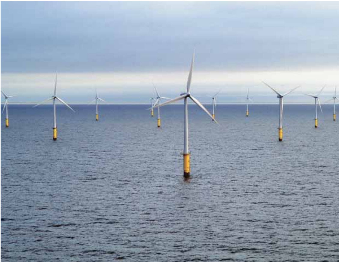
Offshore vindmølleparken North Hoyle bestående af 30 stk. V80-2,0 MW vindmøller er etableret ca. 7 kilometer fra nordkysten af Wales, Storbritannien.
