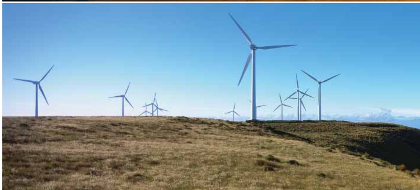
37 stk. V66-1,75 MW vindmøller opstillet på Woolnorth siden i Tasmanien, Australien
