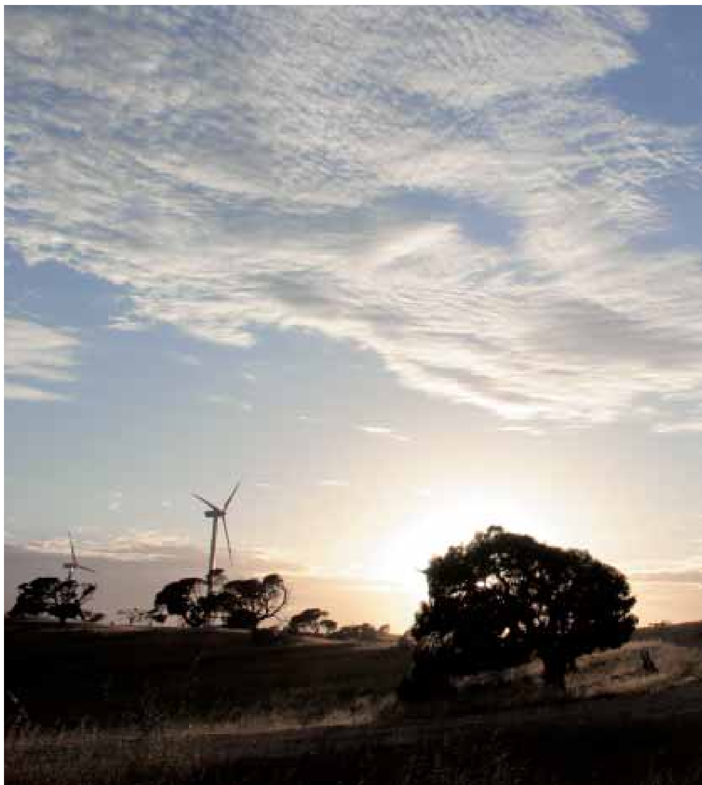
46 stk. V66-1,75 MW vindmøller opstillet på Lake Bonney siden, Australien
