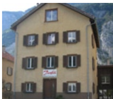
Proenergi Wärmetechnik AG
