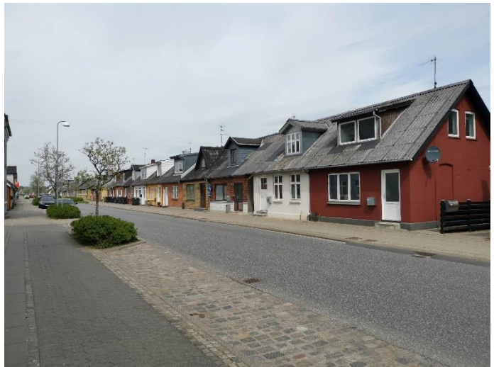
Billede 6: Smederækken på Nørrebro. Flere huse er blevet renoveret eller malet, men den sammenhængende arkitektur er stadig synlig.
