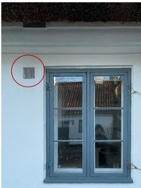
Figur 50: Placering og udformning af ventilerne i boligens ydervæg. Ventilen til venstre er til køkkenet, til højre er ventilen til badeværelset.
