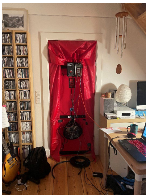
Figur 27: Blower door test udstyr monteret i døråbningen mellem stuen og indgangen.
