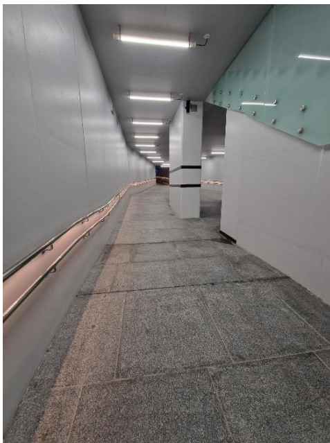
Figur 18 viser armaturer i tverrhallene mot undergang, samt belysning i håndløper (Foto: Hege Narvåg).
