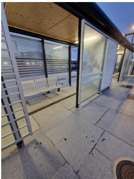
Figur 16 viser klimabeskyttelse på plattform med benk (Foto: Hege Narvåg).
