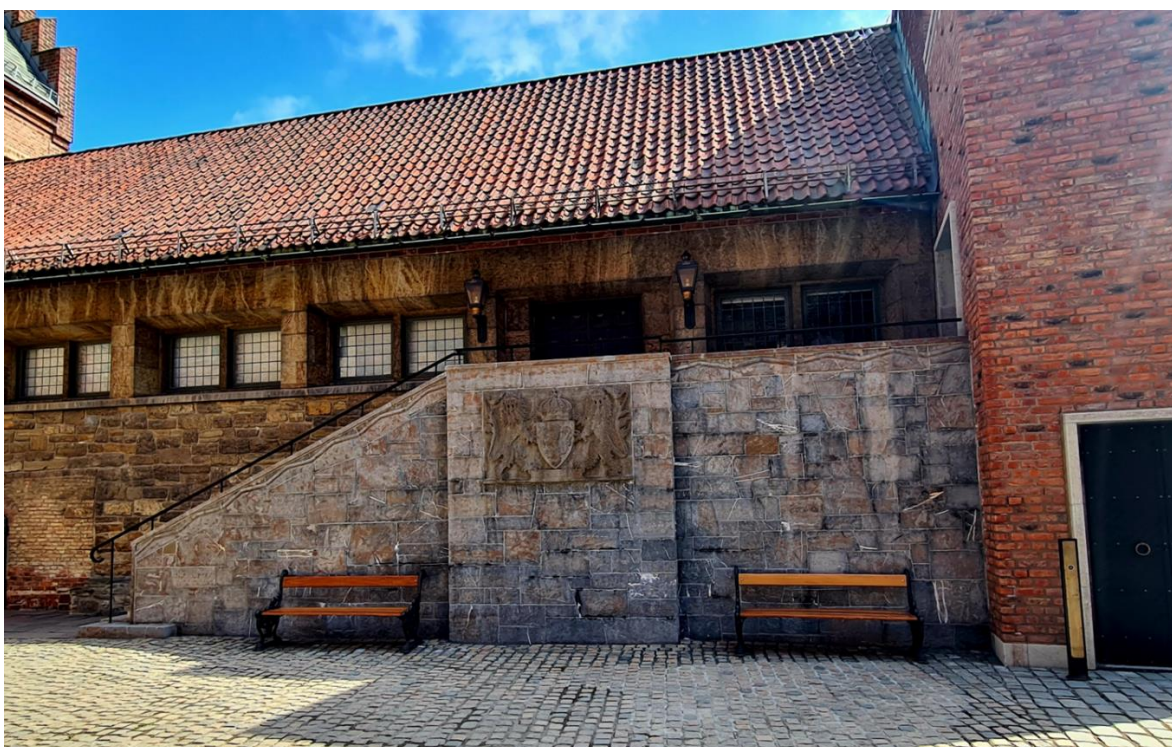
Fig 4 Fateburgalleriet og Arnebergtrappen mai 2023, med heistårnet til høyre. Foto: Oddbjørn Sørmoen
