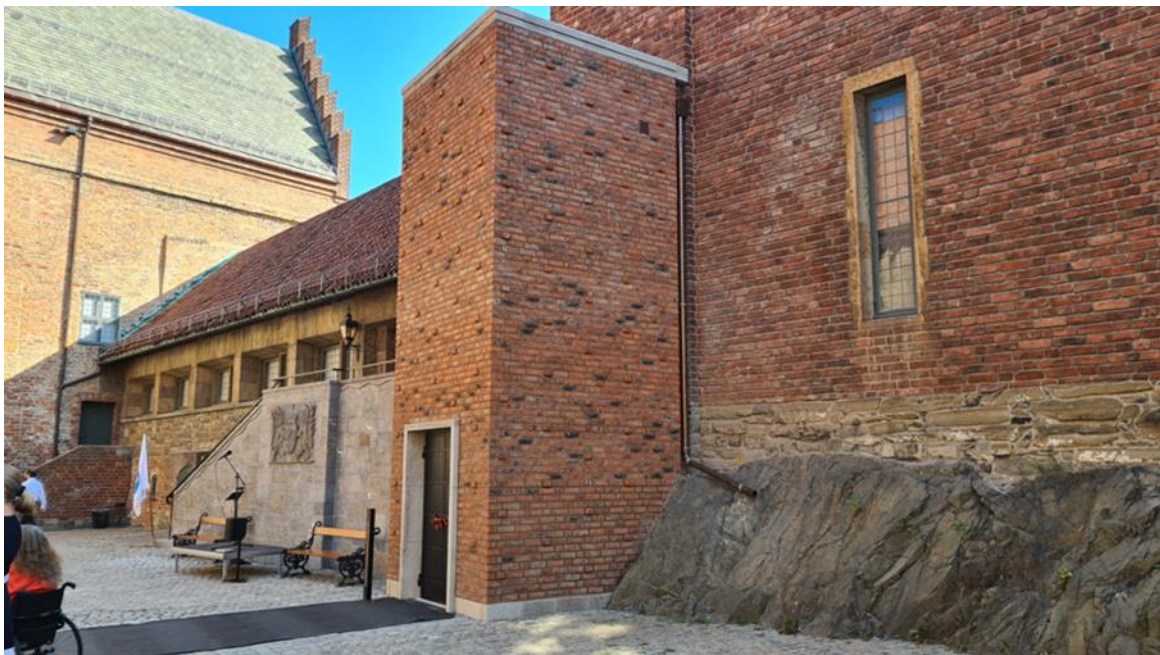
Fig 5 Fateburgalleriet og Arnebergtrappen med den nye heistilbygget på åpningsdagen 2. september 2021. Foto: Oddbjørn Sørmoen
