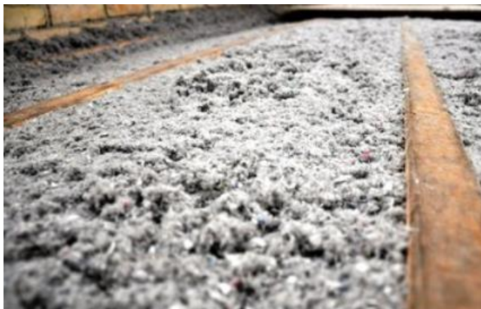
Figur 16 - Celluloseisolering indblæst på loft
