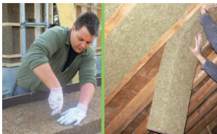
Figur 13 - Græsisolering som tildannes og installeres i loftskonstruktion (Havnens-H, 2023)
