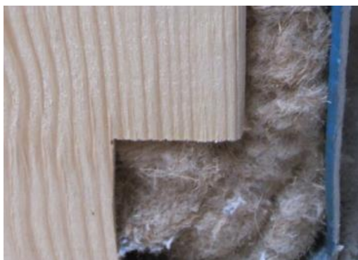
Figur 14 - Træfiber blæst ind som løssuld
