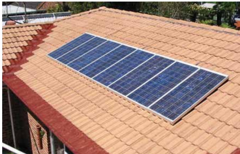
ill. 1.2 - solceller bliver ofte placeret som en addition på tage og facader. Det er ikke altid at denne løsning giver noget positivt til bygningens æstetiske udtryk.
