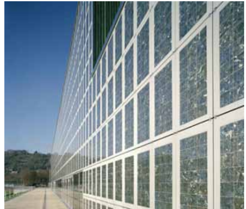
ill.3.19 - Solceller som vægbeklædning på Paul-Horn Arenaen i Tyskland
