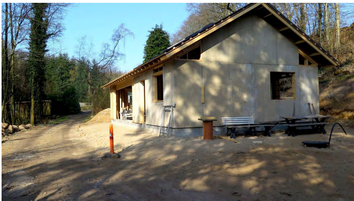
Billede af Celine og families nye hus på under 100 m 2 (kilde: eget fotografi)
