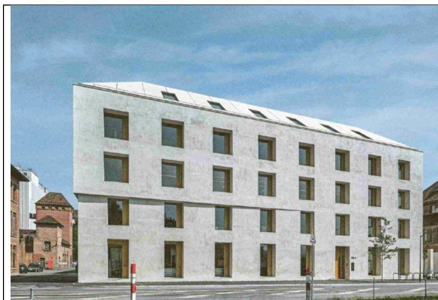
Figur 50, 2226 Emmenweis, Baumschlager Eberle ude fra. Facade i kalkpuds, vinduerne i egetræ.
