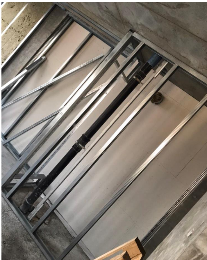
Figur 09: Eksempel på bagvægge der må lukkes, før staldarbejdet kan fortsætte.
