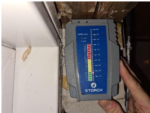
Figur 37 Billede fra bygningsgennemgang viser den benyttede stikbensmåler fra Storch (Eget foto)
