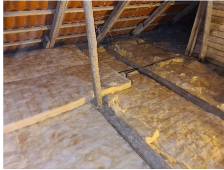
Figur 30 Efterisolering af loft som det specifikt udførte i to lag, set fra loftrummet. (Eget billede af udført loftisolering halvvejs i processen)
