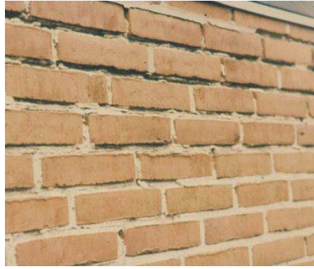
Figur 14. Eksempel på frostskaadet murværk ( (19) BYG-ERFA (21) 011001).
