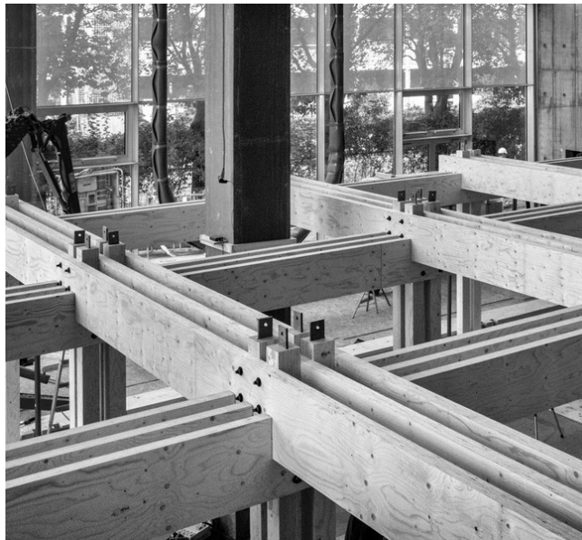
ill. 245. Load-bearing structure, Mediatek, Arkitektskolen Aarhus by Praksis Arkitekter
