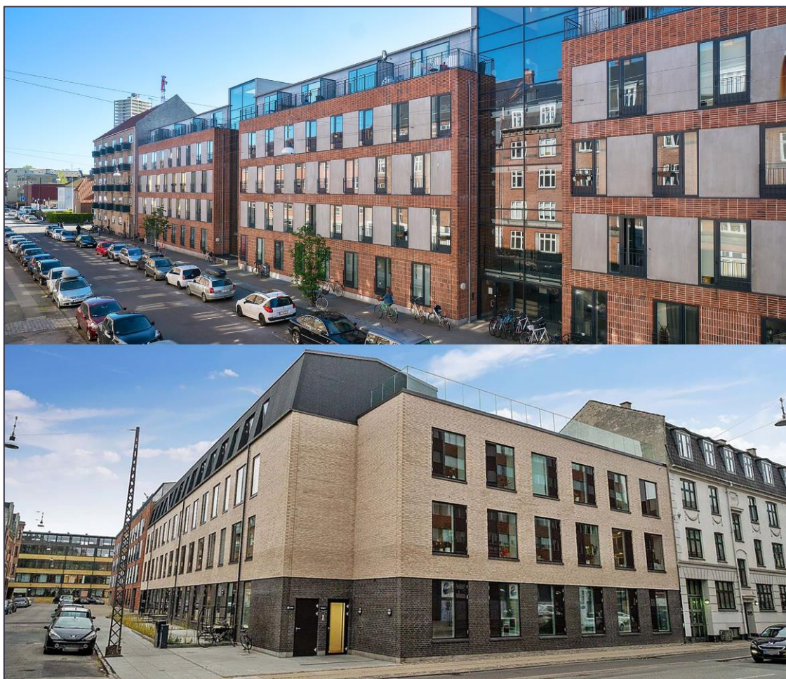
Figur 33 øverst er bygget fra 2006. Nederst er bygget i 2019.
