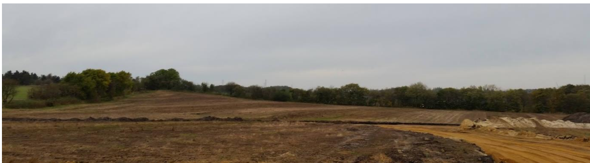
Billede 3: Område for etape 2 bagerst i billedet, billede taget fra syd. Det forreste i billedet, er etape 1 som er ved at blive byggemodnet.
