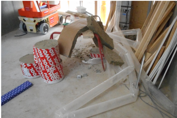
Figur 19, Fotoeksempler fra byggepladstilsyn visende oplag af byggematerialer og udbredt besmudsning af organisk støv. Kilde: sagsarkiv OBH Rådg. Ingeniører A/S.
