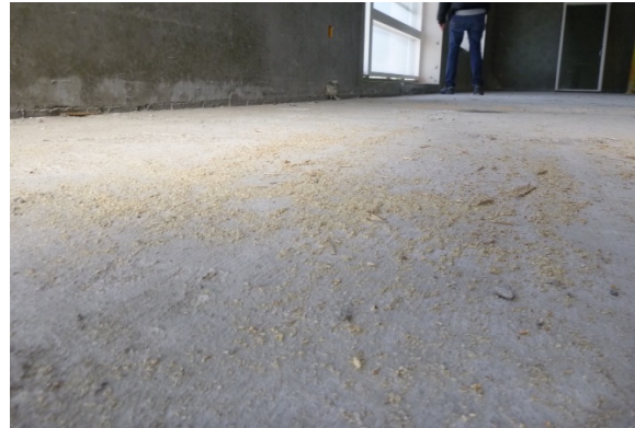
Figur 19, Fotoeksempler fra byggepladstilsyn visende oplag af byggematerialer og udbredt besmudsning af organisk støv. Kilde: sagsarkiv OBH Rådg. Ingeniører A/S.
