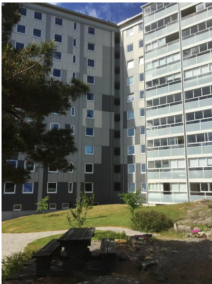
Figur 9 Stjernehus Borettslag. Fasade og uteareal mot syd etter oppgradering. Adkomst med fast dekke til sitteplass. Uteplassen er laget som et bindeledd mellom blokka og naturområdet. Foto: Moen, O. H.
