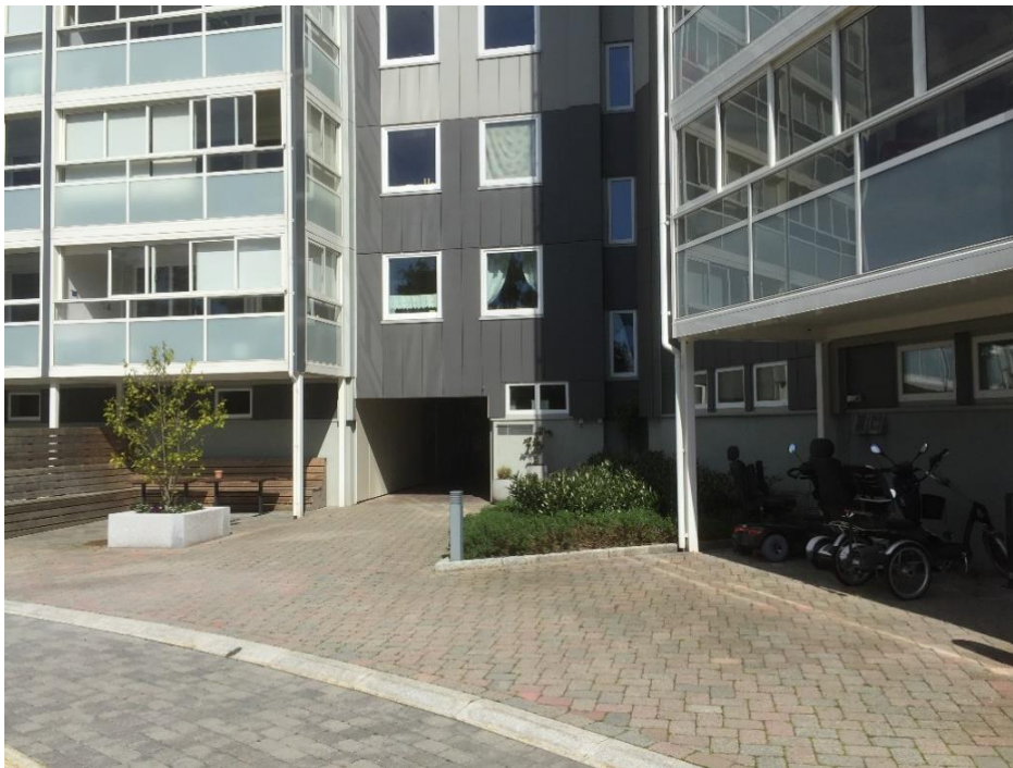
Figur 8 Stjernehus Borettslag. Inngangsparti etter oppgradering. Trinnfri adkomst, sitte/hvilegruppe, parkering m/lading under tak for el. scootere. Foto: Moen, O. H.
