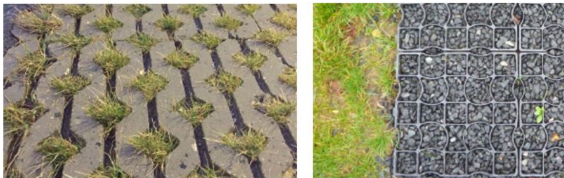
Figur 2.6: Billede af permeabel belægning med græsarmering og grusopbygning. Kilde: [Aalborg Kommune, 2016].
