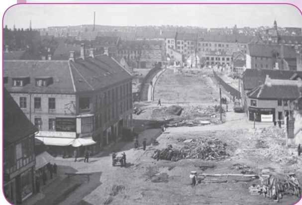
Byggearbejde på Vesterbro. Her laa den gamle sprittfabrik og Cimbertyren kommer senere til at staa her.
