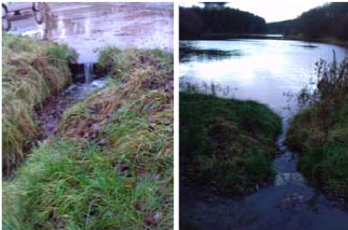
Figur 3.10a og b viser overfladeafstrømningen fra oplandet, der samles på parkeringspladsen nedenfor Nolsvej og føres videre ud i Nols sø. Figur a til venstre viser afstrømningen til Nols sø fra parkeringspladsen. Figur b til højre viser placeringen af afløbsrenden i forhold til søen. Billedet er taget fra søens sydlige ende.
