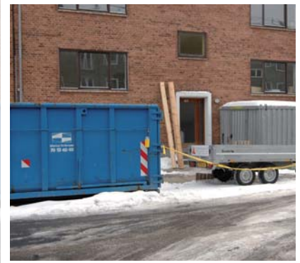
III. 4.12 Tømrerne bruger den plads, der er tilgængelig.
