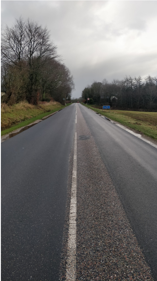
Figur 3.2. Udsnit af belægning på Gislumvej, hvor Gislumvej delvist har fået udlagt slidlag.
