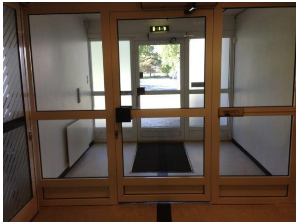
Foto viser todelt glass i dører og sidefelt. Ytterligere glassmarkering er foliering av begge sidefelt ved ytterdør.
