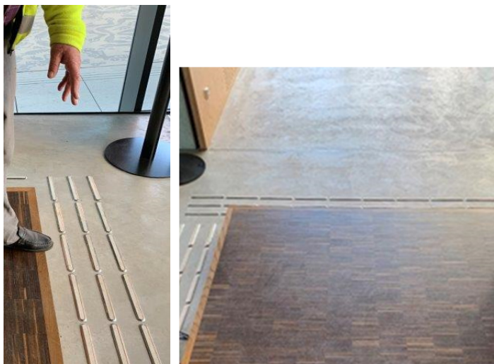
Foto viser oppmerksomhetsfelt i bunn av trapp og overgangen mellom nedre repos og betonggulv i retning motlys.
