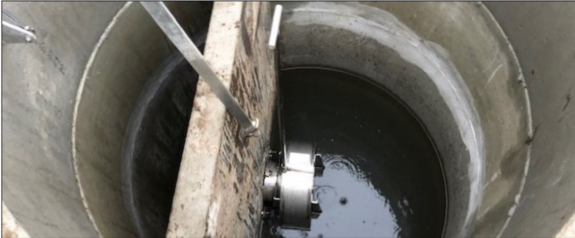
Figur 1.8. Vandbremse i brønd placeret i forbindelse med udløbet fra regnvandsbassinet i Voldum.
