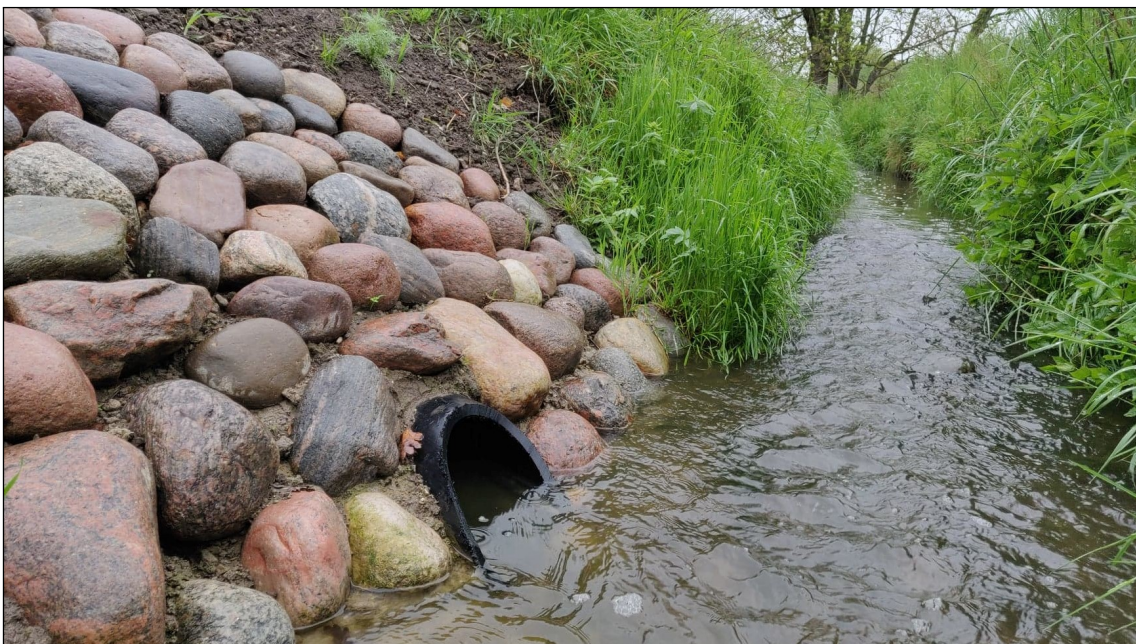
Figur 1.9. Udløb fra regnvandsbassinet til Revens Møllebæk.
