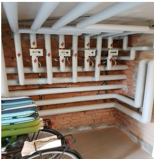
Figur 20 - De nye varmeinstallationer til fire lejermål på Hamlets Vænge 3 samt Hamlets Vænge 2 / Esrumvej 54
