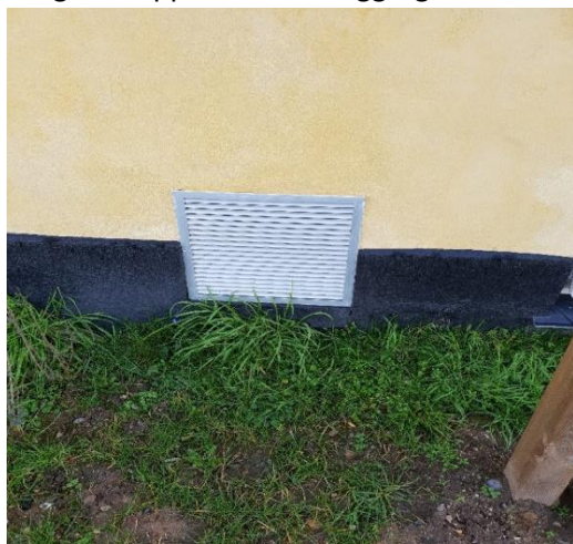
Figur 19 - Den generelle placering af friskluftindtag og afkast til de mekanisk balancerede ventilationsanlæg
