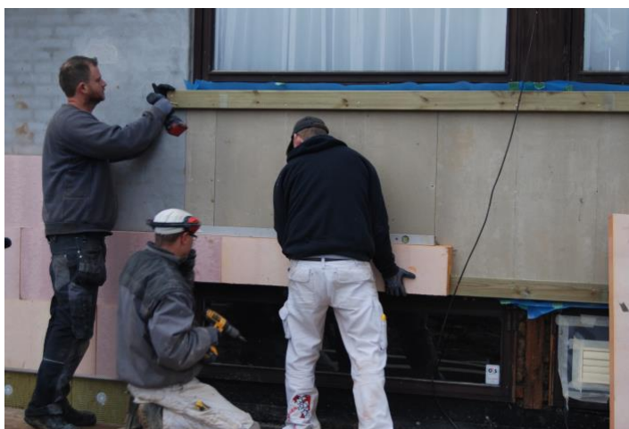
Figur 34: Udvendig efterisolering af let og tung ydervæg (hulmur) på parcelhus fra 1967 udført i november 2013 (Charlottenlund)
