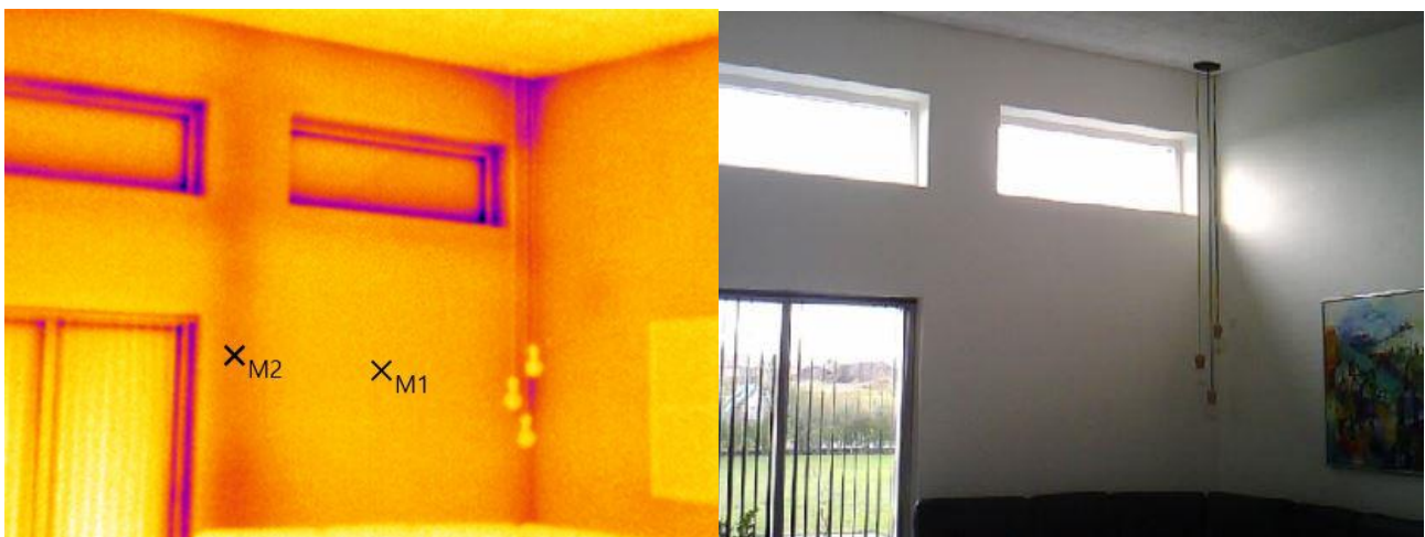
Billede 26 - Termografi af indvendig side af ydervæg med indbygget HEB120 profil (tv) samt tilhørende realbillede af ydervæggen (th). M1=23,8^{\circ}\text{C} . M2=24,2^{\circ}\text{C} .
