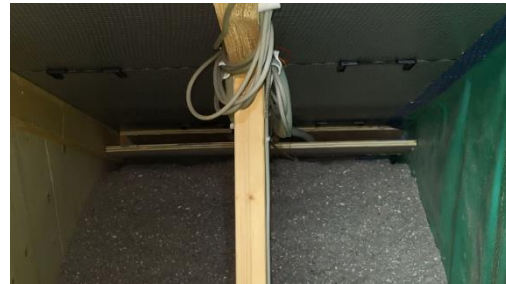
Figur 34: Tagrum MX.4 med 400 mm cellulose. Isoleringen holdes på plads af et vindbræt, som sikrer en ventilationsspalte på 30 mm i højden.
