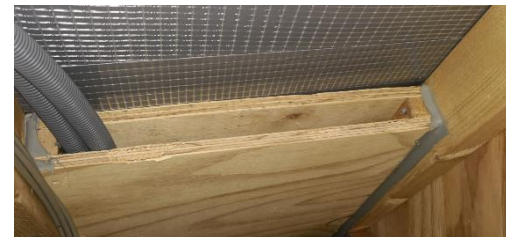
Figur 35: Vindpladen er fuget langs spærtræ og samlinger for at sikre lufttæt alle andre steder end i selve åbningen.
