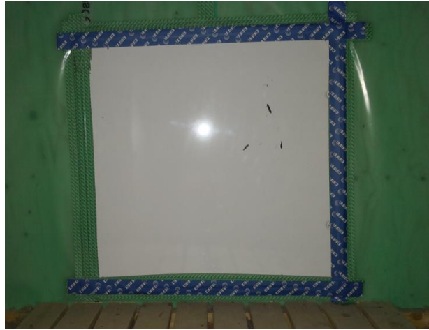
Figur 22: Adgangslem mellem to tagrum. Forseglet med grøn og blå dampspærretape fra Dafa, således at luft- og damptæthed bliver bedst muligt sikret.
