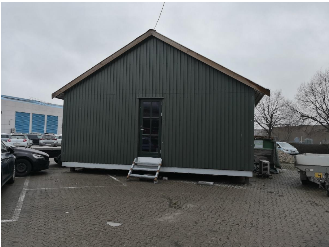
Figur 28: billede af SBI's testhus. På billedet ses vest gavlen og indgangen til sektion M1 og M2.
