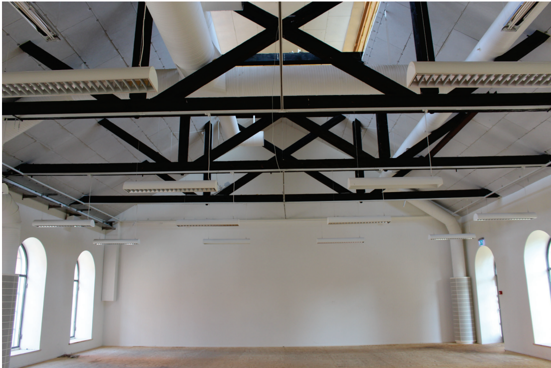
Figur 7. Viser hvordan kedelrummet ser ud i 2019, 113 år efter opførelsen af kedelbygningen.
