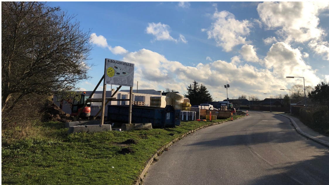
Figur 2.4: Nyt mindre boligområde i den sydvestlige ende af byområde 5.5.B1. Byggeriet omfatter opførsel af 6 boliger af 95 m 2 , som forventes indflytningsklare i sommeren 2019.
