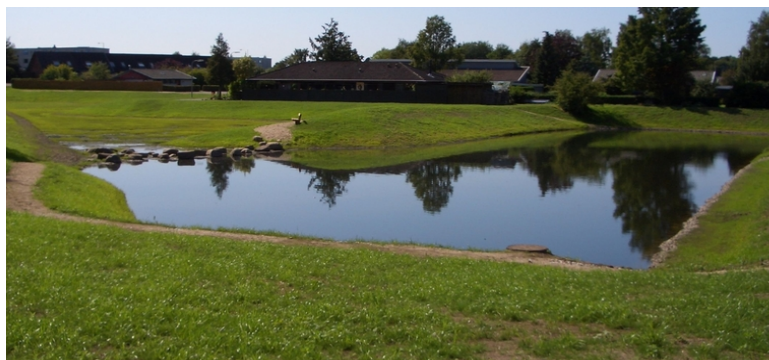
Figur 15: Regnvandsbassin i Sanderum på areal, hvor der før lå huse (Odense Kommune og VandcenterSyd 2015)
