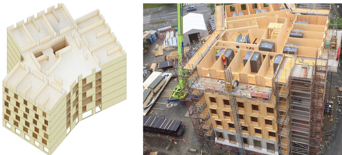
Figur 5.4: Til venstre ses en model af det statiske system, udgjort af CLT-elementer [Arkitektur N, 2018]. Til højre ses et af tårnene under opførelse [Træ.dk, 2016].
