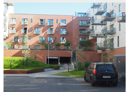
Figur 6.20. På billedet ses indgangen til den omtalte parkeringskælder.
