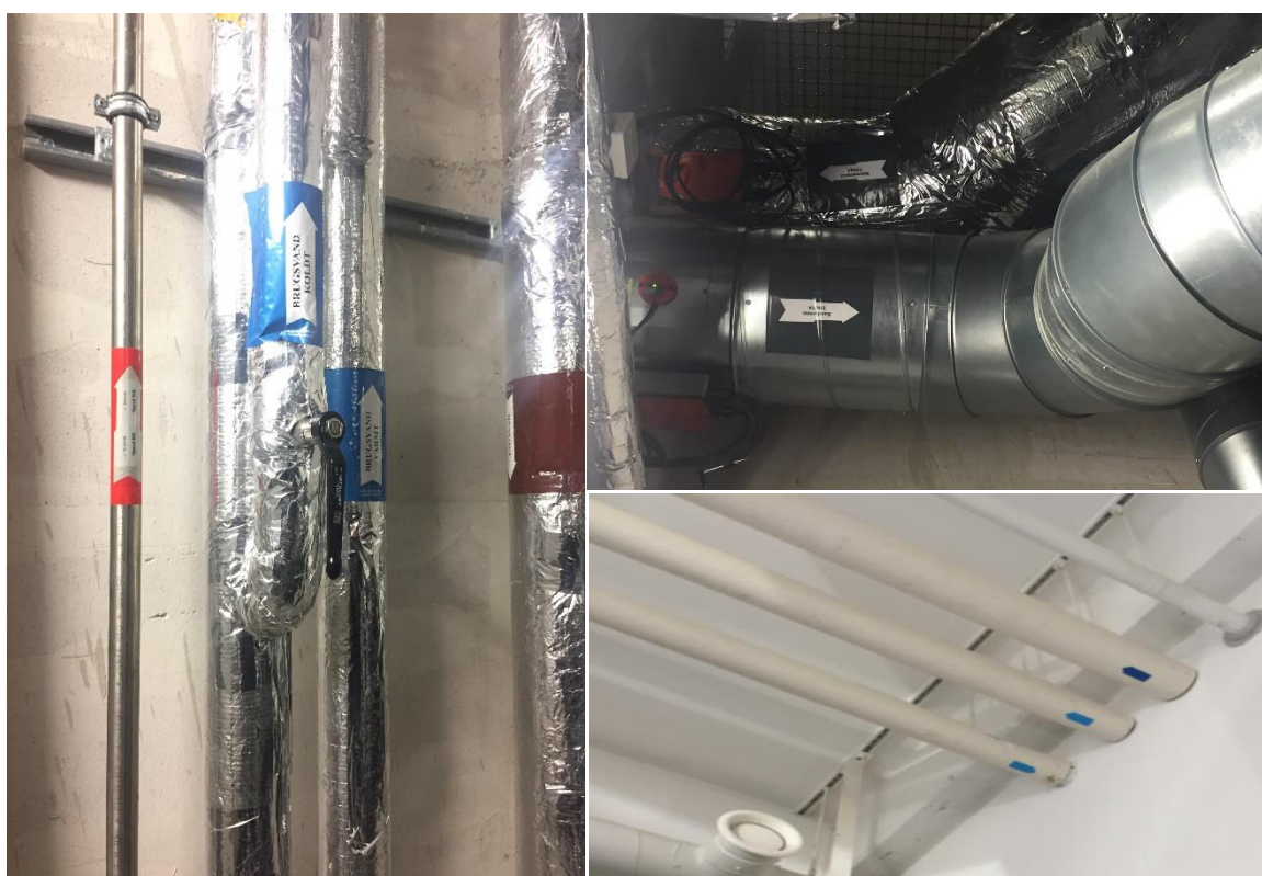
Figur 6-12 Indikation af forsyningsretning. Billeder taget ved observation
