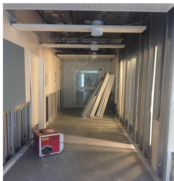
Figur 6-10 Fjernet loftplader og nedrevet indervægge ved udbedring af vandskade. Billede taget ved observation
