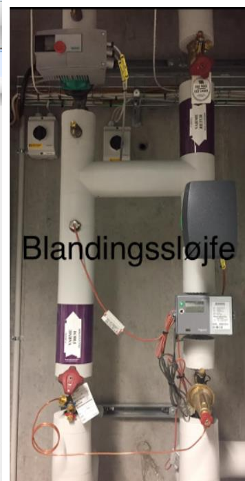
Figur 6-13 Venstre: Ventilationsdiagram - Højre: Blandesløjfe i teknikrum. Billeder taget ved observation
