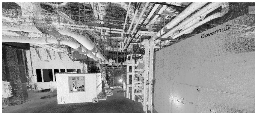
Figur 9-5 Punktskyer af scannet rum med installationer – Billede fra internet: Link- http://ilk.dk/75qe6x
